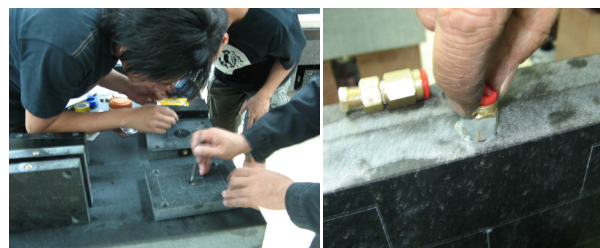
圖六 金屬牙套膠合工作情形
