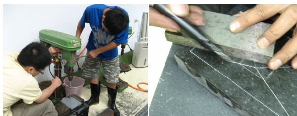
圖五 精密花崗岩構件鑽孔與刻槽之工作情形
