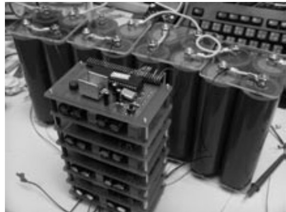
(圖8) 導入超電容控制的電路板
