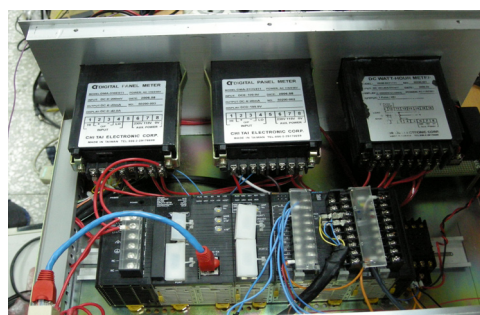
圖8 PLC配電箱實體照片
