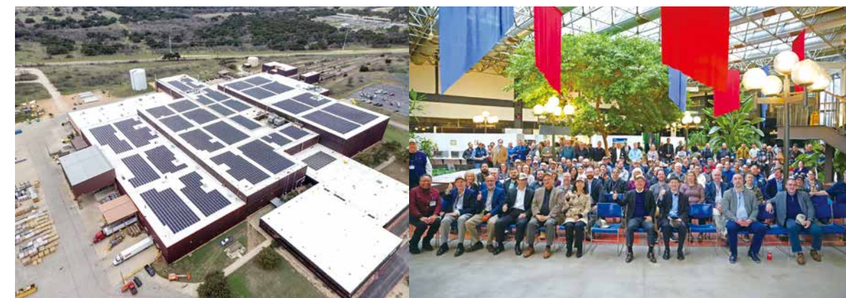
圖 2. TECO-Westinghouse 位於美國德州 Round Rock 的工廠進行的太陽能計畫，是永續發展願景的一環，這座太陽能系統包含 4,320 片太陽能模組與 33 英里長的電線，年發電量達 2.5 兆瓦，並由德州當地領先的再生能源供應商 Solar One 共同執行。TWMC 計畫將所產生的能源用於製造運營，顯著降低對傳統能源的依賴，並監測與分享該系統的效能數據，以實證再生能源投資的實際效益。
