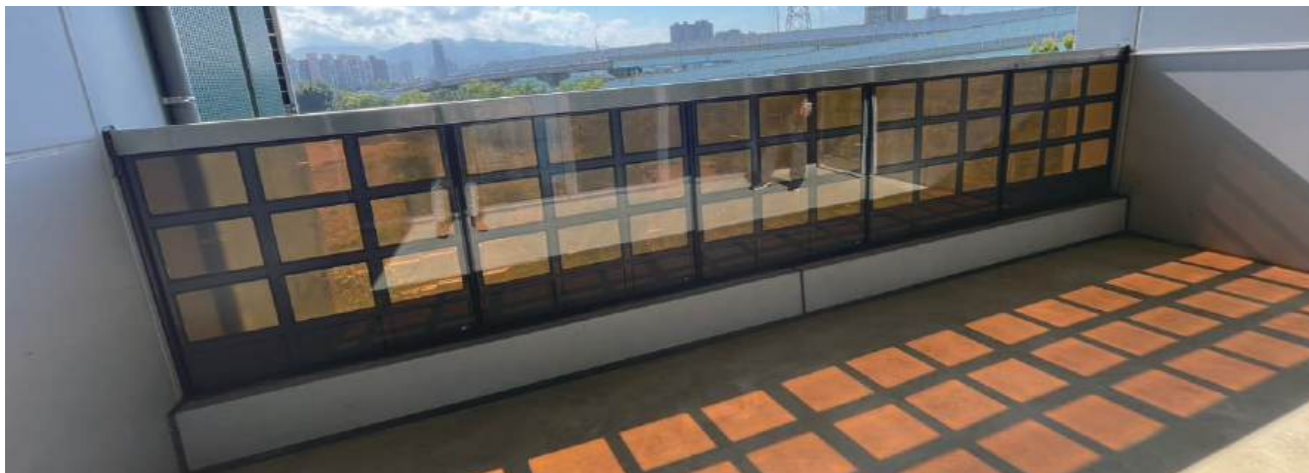
▲ 將鈣鈦礦太陽能電池整合陽台欄杆 圖片提供：台灣鈣鈦礦科技
