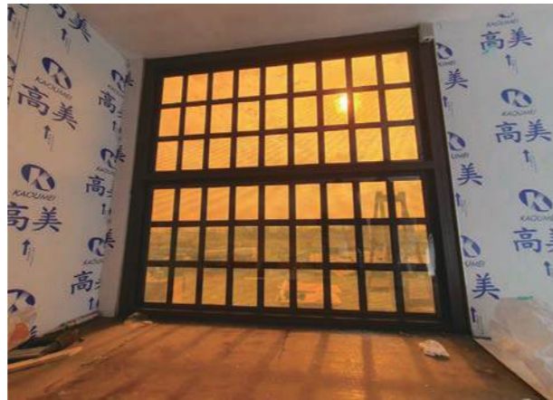
▲ 將鈣鈦礦太陽能電池整合於工務所或是貨櫃屋之實際應用 圖片提供：台灣鈣鈦礦科技
