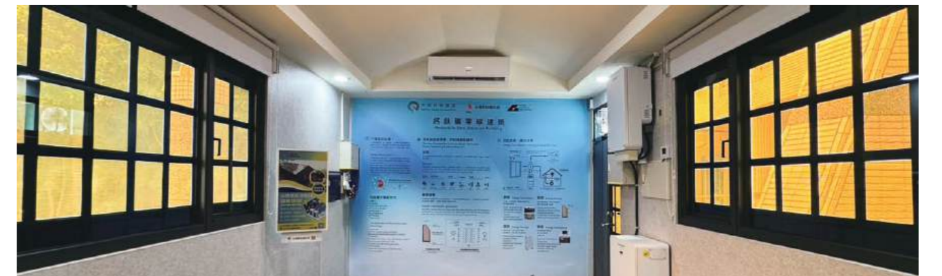
▲ 在窗戶及門上裝置鈣鈦礦太陽能電池，打造自供電零碳示範場域 圖片提供：台灣鈣鈦礦科技
